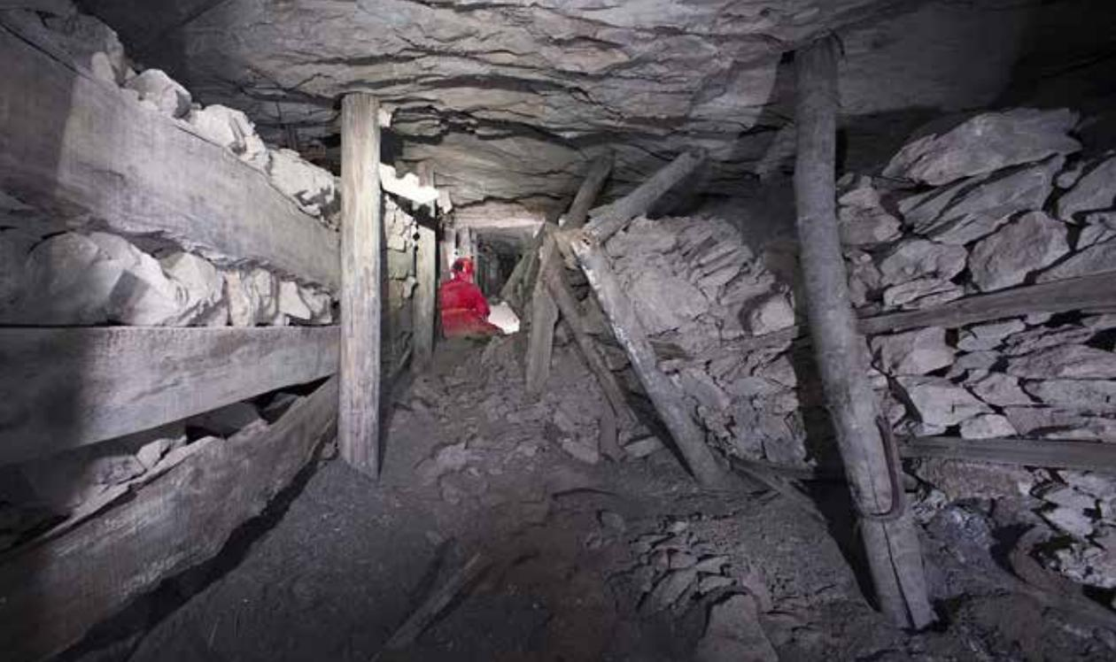
*Miniera di Peticara. Vecchia entrata operai, armature danneggiate dalle ripiene spanciate.*
