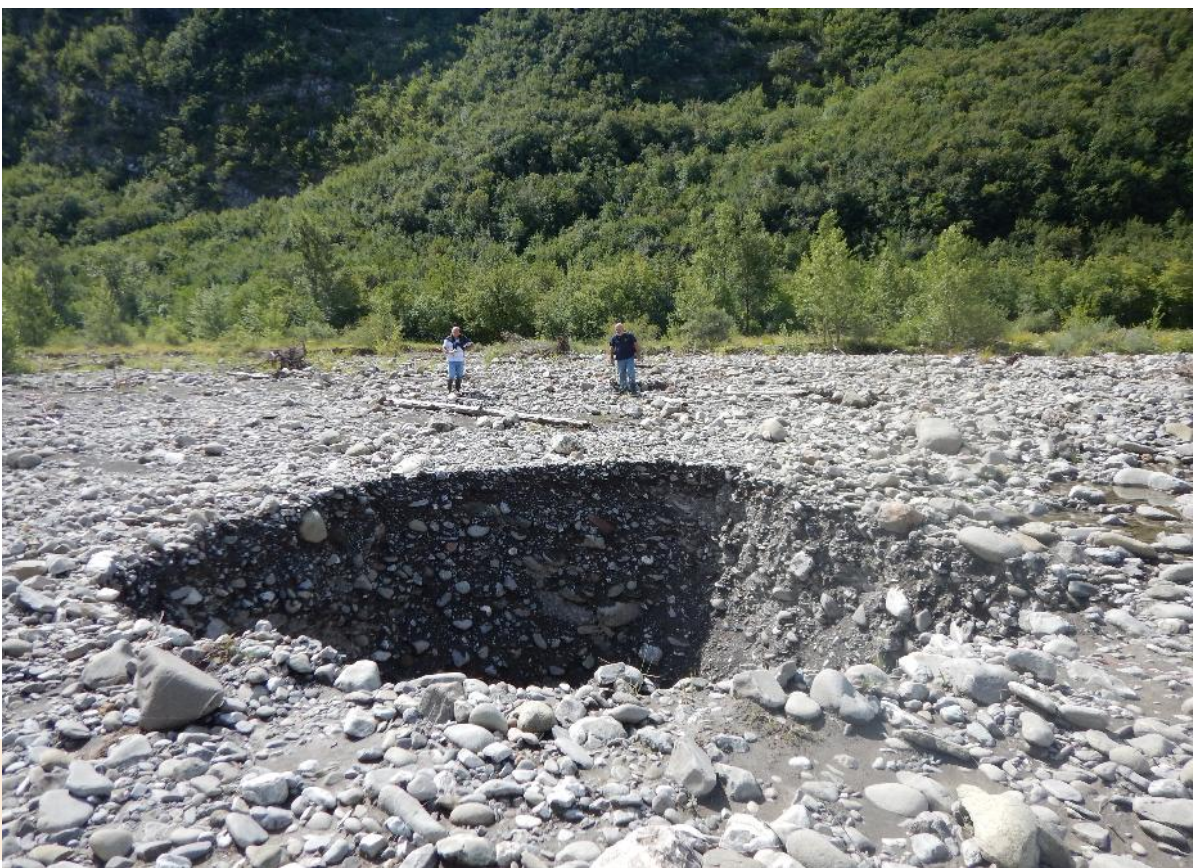
Sinkhole nell'alveo del Secchia.
