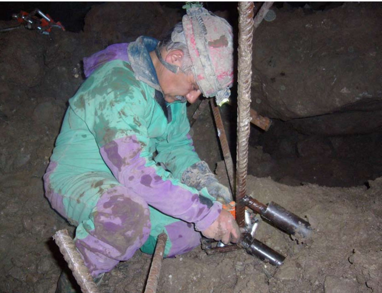
Fig. 1 - Baldo al lavoro per la realizzazione della "gabbia" del Rio Basino (foto P. Lucci).
