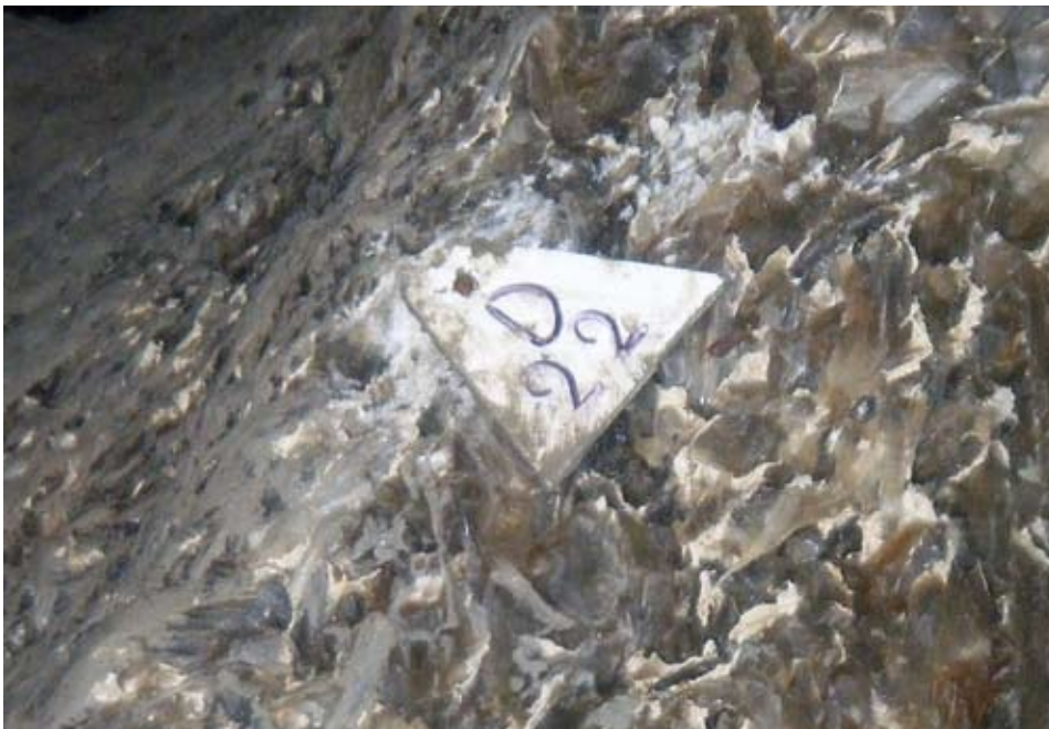
Fig. 3 - Placchetta in "Forex" fissata con chiodo in acciaio che contraddistingue i capisaldi secondari (foto arch. CVSC).
